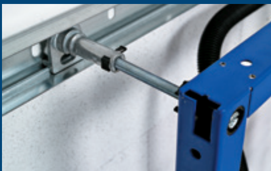
↑ Aseta Geberit Duofix -asennuselementti oikeaan asentoon. Jos asennusseinä on huonekorkeutta matalampi, käytä seinäankkurointia...
