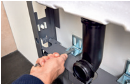
↑ Kehys kiinnitetään rakennuksen rakenteisiin toimiviksi todetuilla kannakkeilla.
