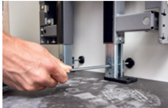
↑ Kehyksessä on kaksi säätöruuvia, joilla voi kompensoida seinän vinoutta.
