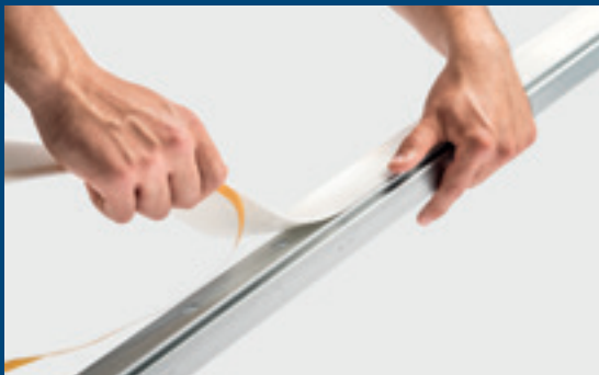
↑ Aseta kiskoihin Geberit Duofix -eristysnauha ja kiinnitä ne lattiaan sekä kattoon.
