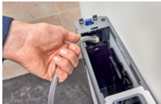
↑ Vesikytkentään tarkoitettu teräsvahvikkeinen punosletku voidaan asentaa ilman huuhtelusäiliön irrottamista – yksi vaihe vähemmän!
