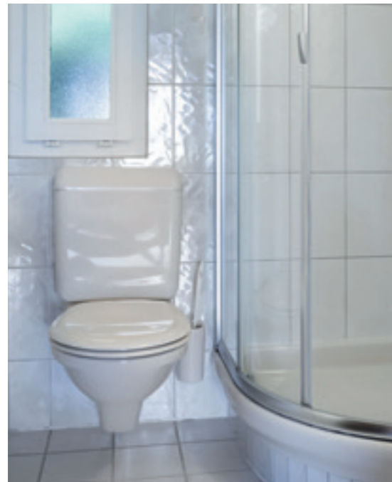
ENNEN Vanha wc seinäviemäröinnillä
