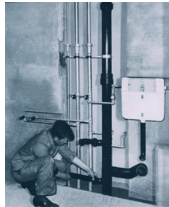
↑ Turvallisesti seinän takana – Ensimmäinen piilohuuhtelusäiliö vuodelta 1964.
